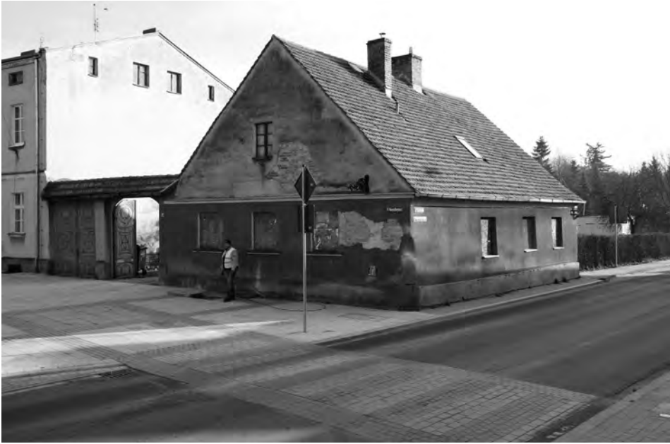
Il. 3. Budynek narożny (dawna giełda), widok od rynku, stan obecny. Fot. Mikołaj Potocki
