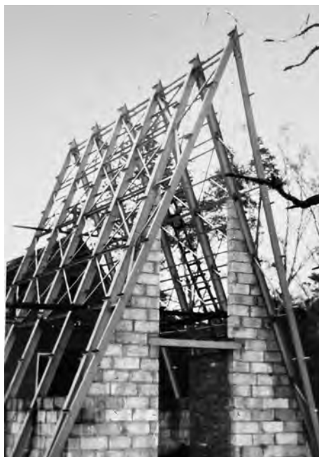
Il. 4. Budowa kościoła filialnego w Radzewicach. Styczeń 1976. Zdjęcie ze zbiorów Marcina Libickiego
